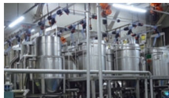
新設した もち米の浸漬タンク
